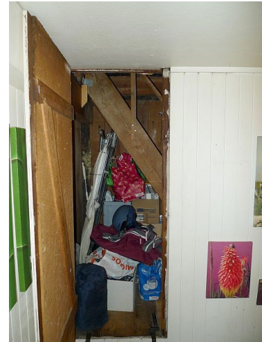
32 Zugang ab OG zu Dachboden DG
